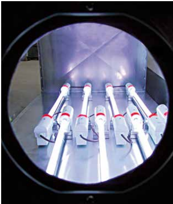
> NORKA-Leuchte NEUSTADT mit T-UV-C-Lampe zur Entkeimung in Luftfilteranlage
